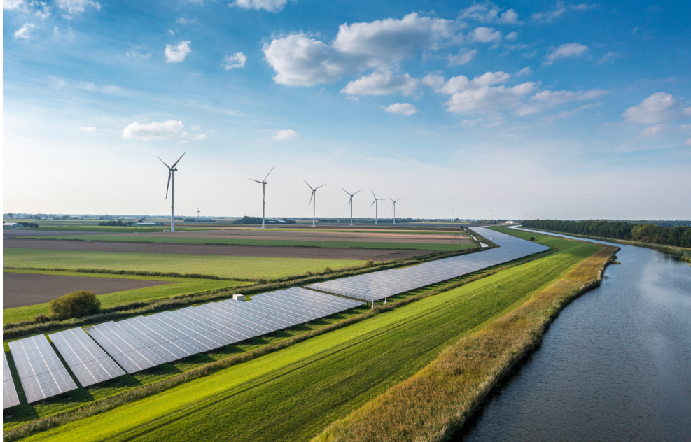
WINDTURBINES EN ZONNEPANELEN LANGS HET GROETKANAAL TE WINKEL (NH)
