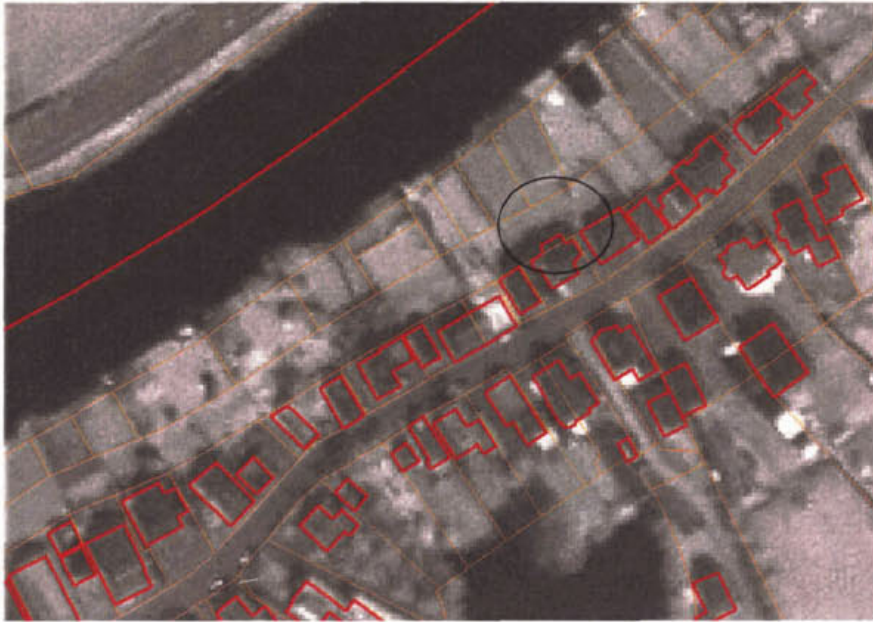
Figuur 2-25 Eemdijk met DKK
